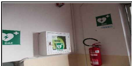
INGRESSO PALESTRA PIANO PRIMO
